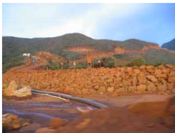
工事の状況 (2006 年撮影)
