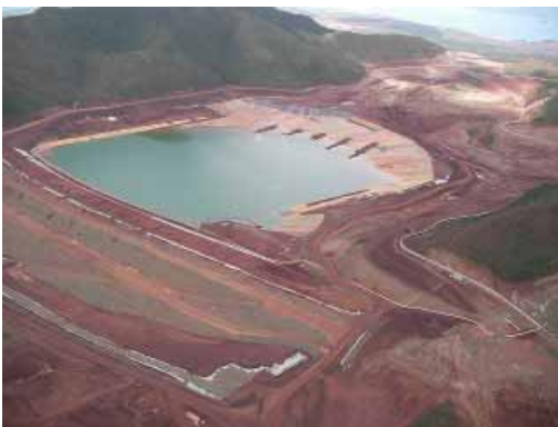
テーリングダム。精錬過程で発生する大量の残渣をここに貯留します。
