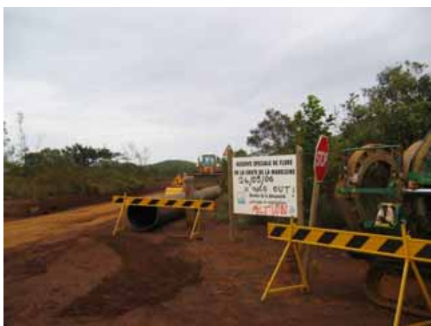
精錬所から採掘場に至る道。パイプライン敷設中。看板は Nothern Forest Reserve を示すもの。「事業者は、出ていけ」との落書きがあった。当時、住民による激しい反対運動と道路封鎖がありました。(2006 年撮影)
