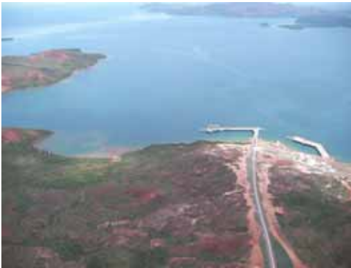
積み出し港。ここから精錬されたニッケル、コバルトが積み出されます。輸出先には日本も含まれています。
