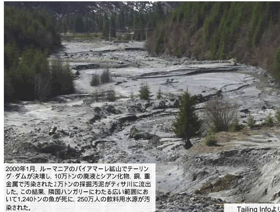
2000年1月、ルーマニアのバイアマーレ鉱山でテールング・ダムが決壊し、10万トンの廃液とシアン化物、銅、重金属で汚染された2万トンの採掘汚泥がティサ川に流出した。この結果、隣国ハンガリーにわたる広い範囲において1,240トンの魚が死に、250万人の飲料水水源が汚染された。
