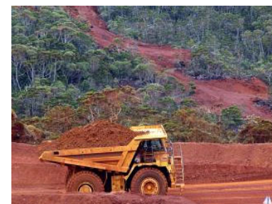
鉱山採掘場表土掘削作業
