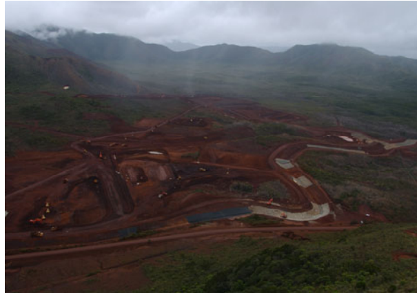
テーリングス・ダム建設現場(2006・11)
