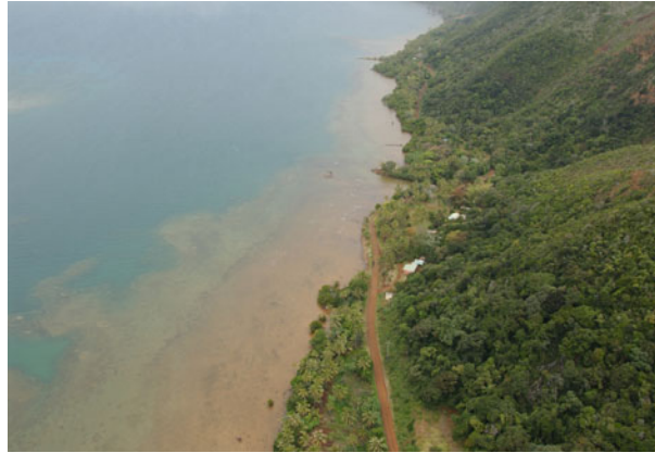
ゴロー地区への赤泥の浸出状況(2006・11)
