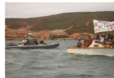
リブ・ヌウと漁民による排水パイプ敷設妨害
