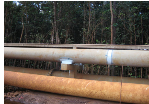
特別植物保護区端を横切るパイプ(看板撤去2009・4)
