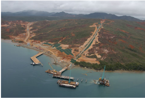
製品出荷・資材荷上げ桟橋(2006・11)
