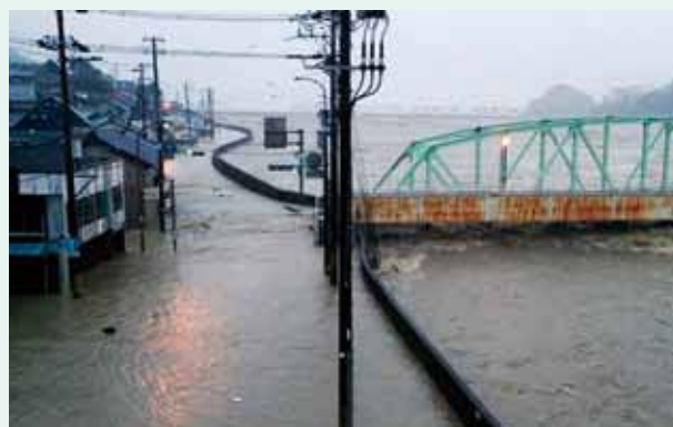
熊野川が氾濫し、冠水した国道42号線 ★出典 6
