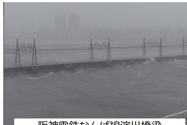
阪神電鉄なんば線淀川橋梁 (大阪市西淀川区) の状況 (近畿地方整備局提供)
