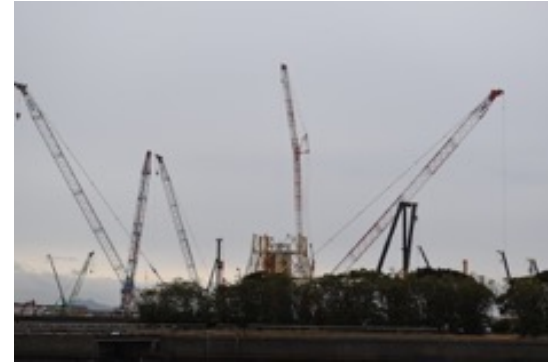
新設工事が進む横須賀石炭火力
