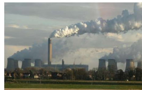
Power Plant 発電所
