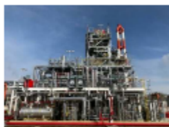
環境に配慮したエタノール由来のエチレン試験製造設備 (千葉県市川市)
