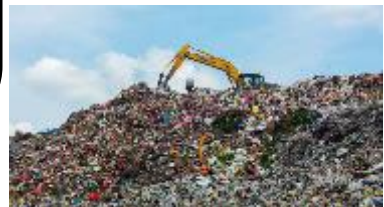
(現地最終処分場作業風景 2019年12月)
