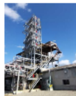
ケミカルリサイクル実証設備
