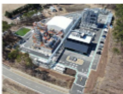
*ごみ由来のエタノール製造実証プラント (岩手県久慈市)
