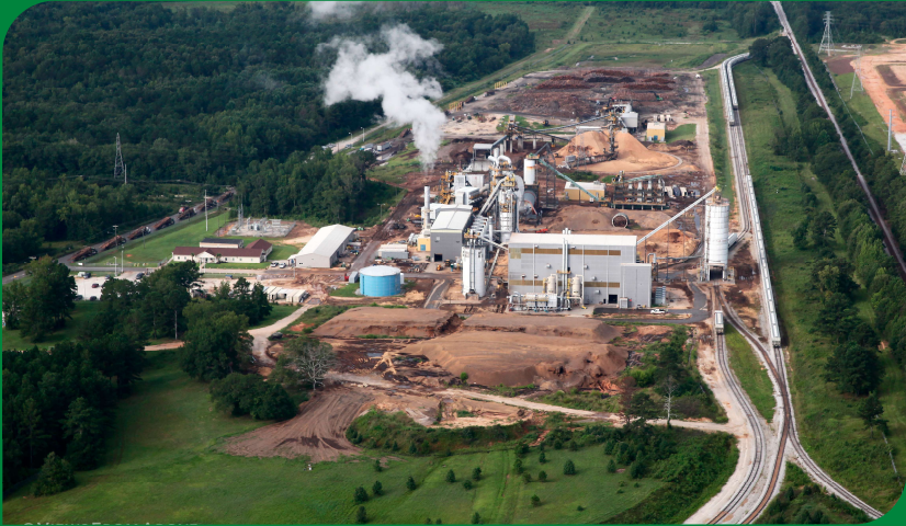
エンビバ社グリーンウッド工場 (サウスカロライナ州) 写真: @ViewFromAbove
